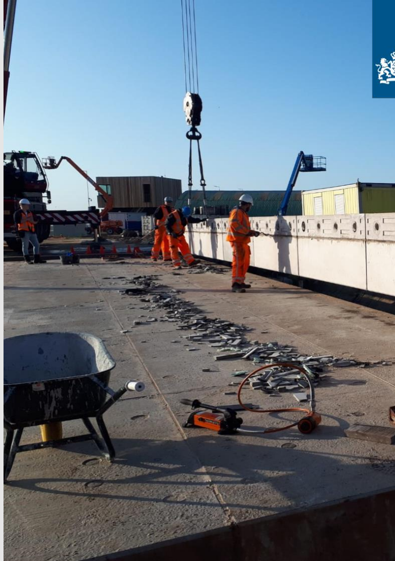
Foto: demontage van het eerste circulaire viaduct
